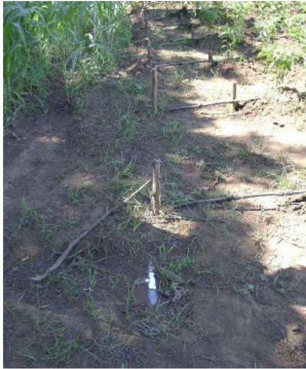
Fotografía 5: Los mangueras PVC deben ser protegidos contra los rayos del sol.
