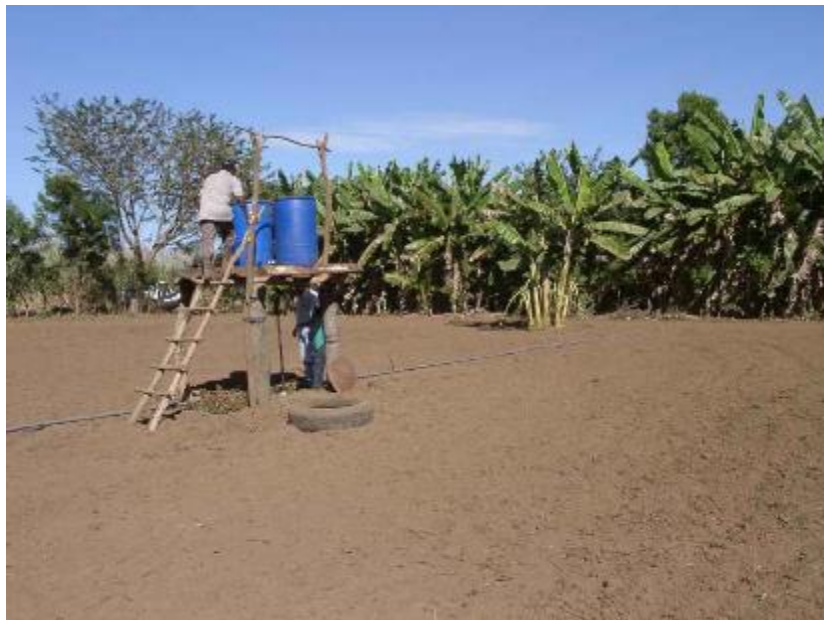
Fotografía 4: Instalación el sistema al inicio del verano.
